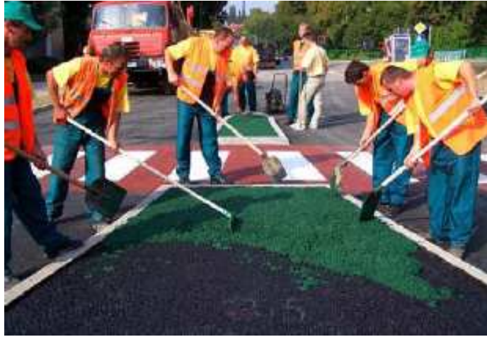
(a) Konstruksi perkerasan lentur menggunakan bioasphalt vegecol TM aspal hayati
